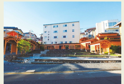
湯路広場にある公衆トイレの外観。
