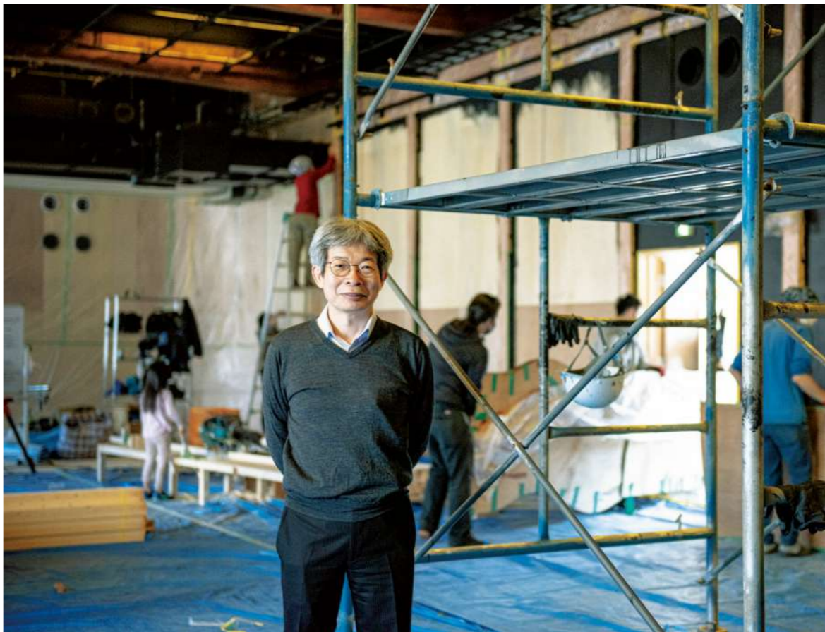
劇場の改装の資金はクラウドファンディングで募った。最後の仕上げは劇団員自らが行ってた。
